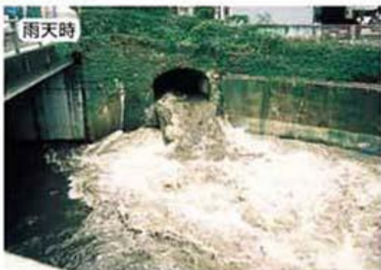
▲一定以上の降雨量に達すると、汚水混じりの雨水が放流されます。
