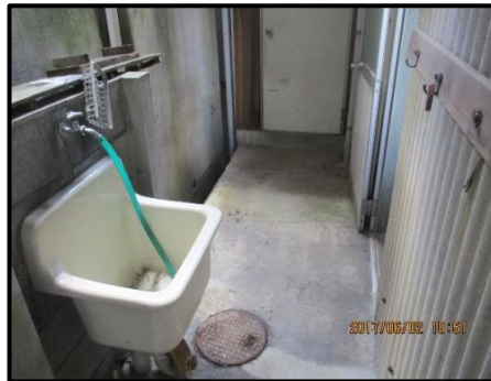
※洗い場:実験機材設置スペース
