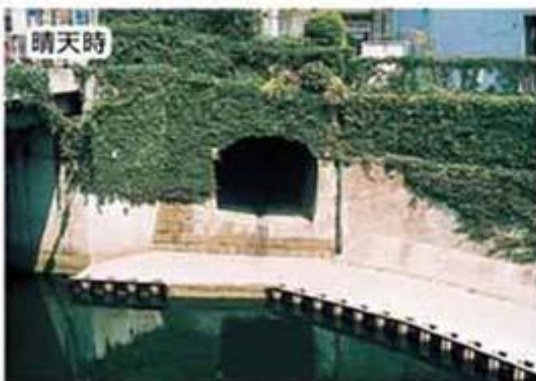
▲晴天時には、下水（汚水）は全て処理場に流れるため放流はありません。
